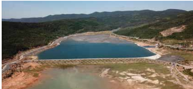
Bãi thải xỉ Công ty Nhiệt điện Nghi Sơn.
